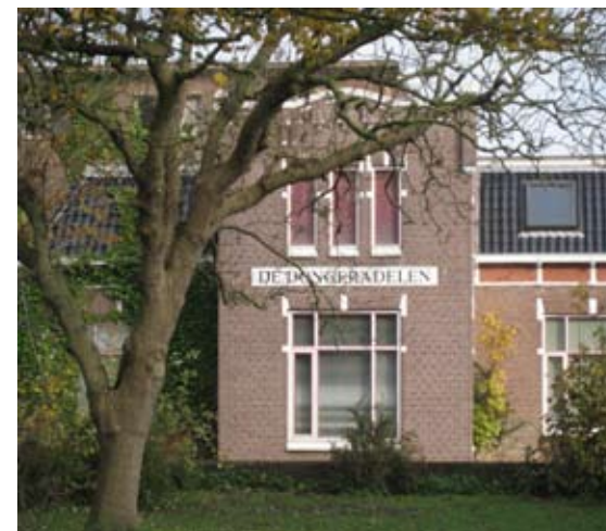
Voormalige melkfabriek 'De Dongeradelen'
